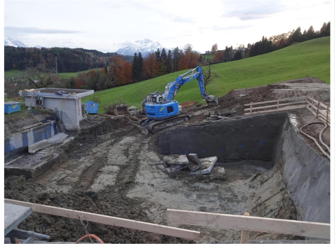
Baugrube für Reservoir-Kammern
