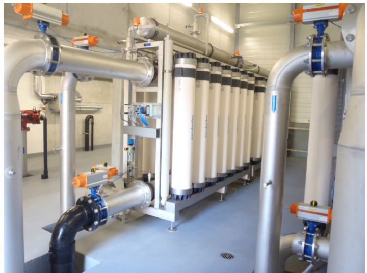
Ultrafiltration Seewasserpumpwerk
